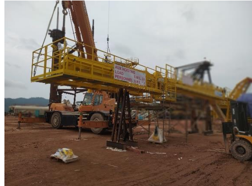
Gambar 10. Pemasangan Boom & Jib Crane
