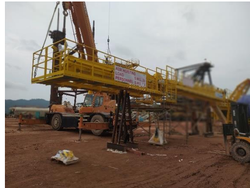
Gambar 10. Pemasangan Boom & Jib Crane
