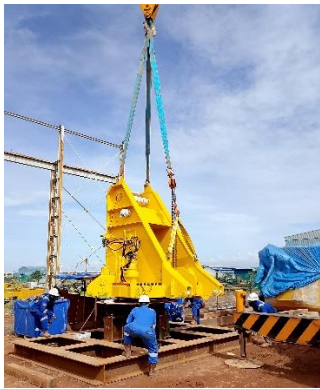
Gambar 8. Pemasangan Turret
