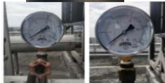
Gambar 8 Kerja VSD terpasang di Pompa
